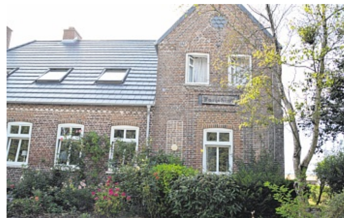
Im Vergleich zum Ursprung von 1890 fehlt dem Haus rechts die eine Hälfte. Mietschulden führten zum Abbruch.
